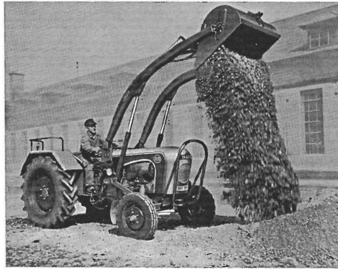
Durch Frontlader Gr. III eignet sich der TL 38 besonders auch für Baustellen und in der gewerblichen Wirtschaft.
